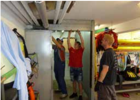
Abbau Kompressor und Abriss des Kompressor-Raumes (Teil 1).
