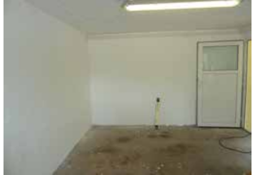
Die Garage wurde vorbereitet und neu gestrichen.
