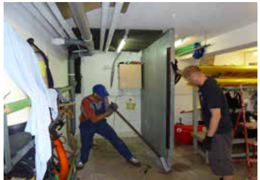
Abbau Kompressor und Abriss des Kompressor-Raumes (Teil 2).
